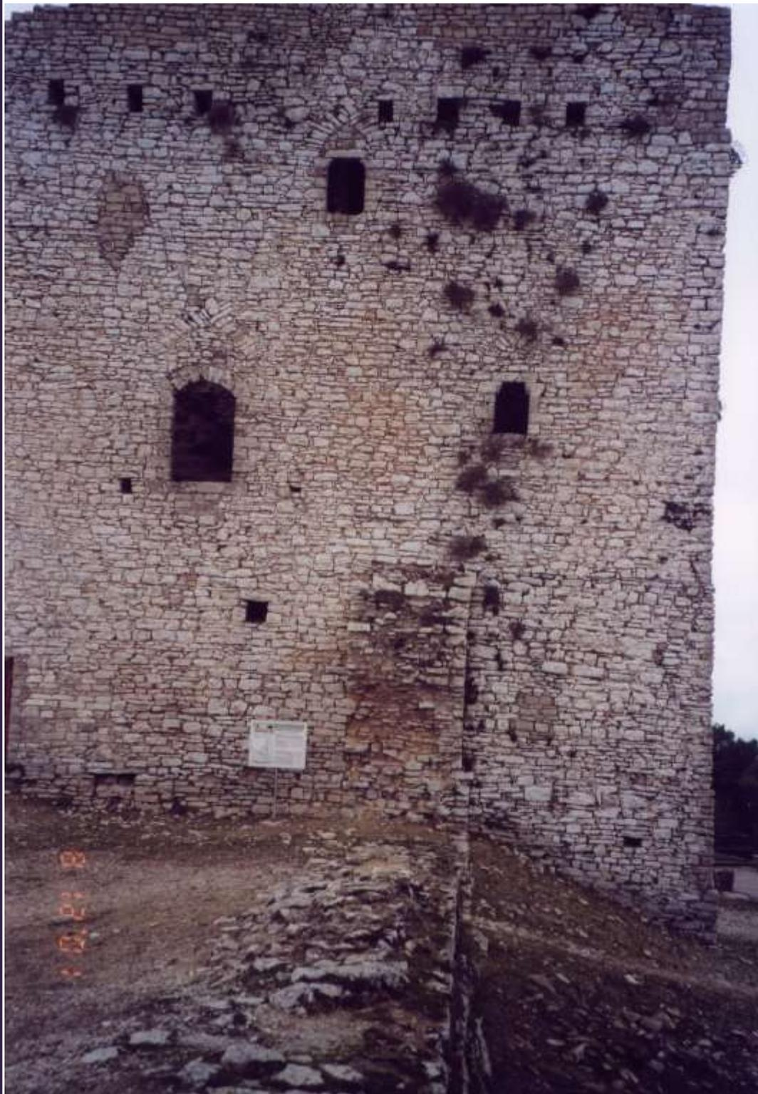
fig. 3 Torre di N-O vista da N-E: visibili i resti delle mura di cinta all'attacco con i fianchi della torre; le aperture con stipiti ed archi di scarico; i fori disposti diagonalmente per una probabile scala che, partendo dalla corte, permetteva l'accesso all'altezza del primo piano; la fila di buchi ad altezza del calpestio della copertura, ancoraggi per eventuali ballatoi d'emergenza.
